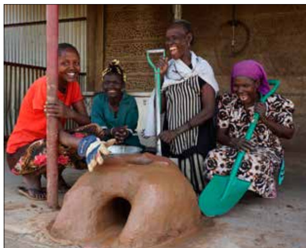
Kvinnorna har lärt sig bygga en bättre spis. I vanliga fall lagar de mat över öppen eld vilket inte är särskilt värmeskapande.
